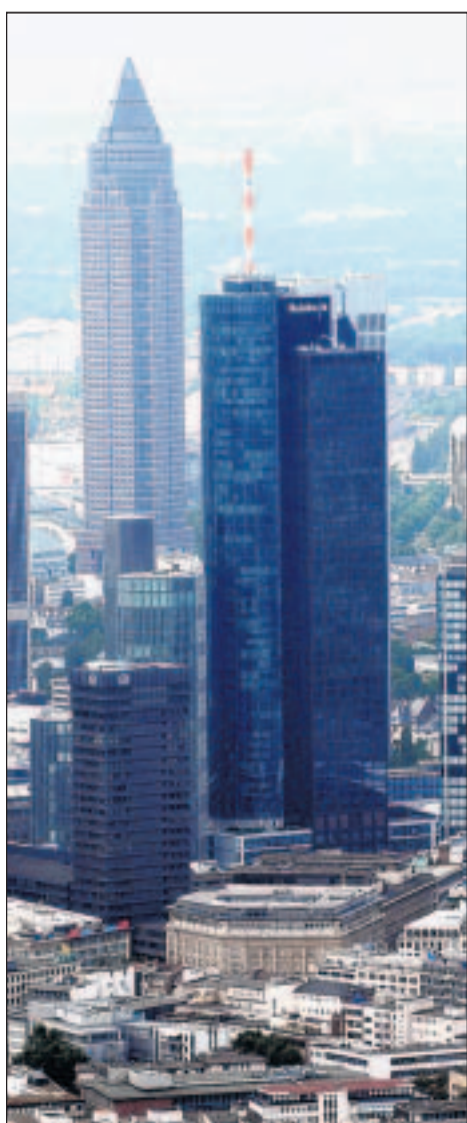
Majestätisch ragen die Kolosse aus Beton, Stahl und Glas in den Frankfurter Himmel.
